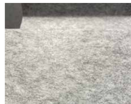
Vliesbeschichtung Normalzustand (Detail)
