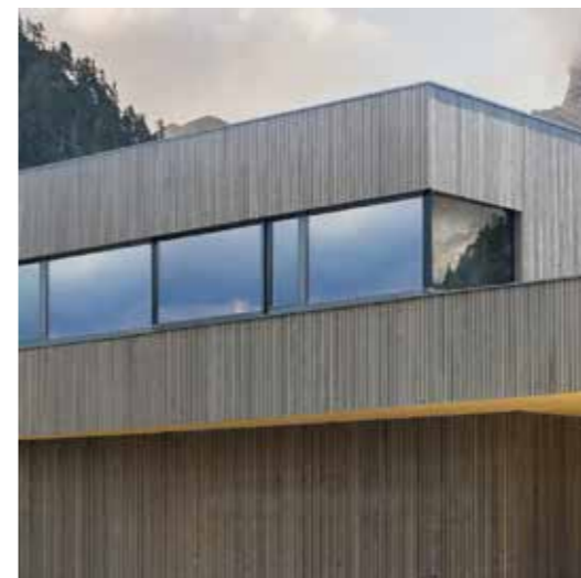
○ Montage einer vorvergrauten Fassade im Jahr 2017
